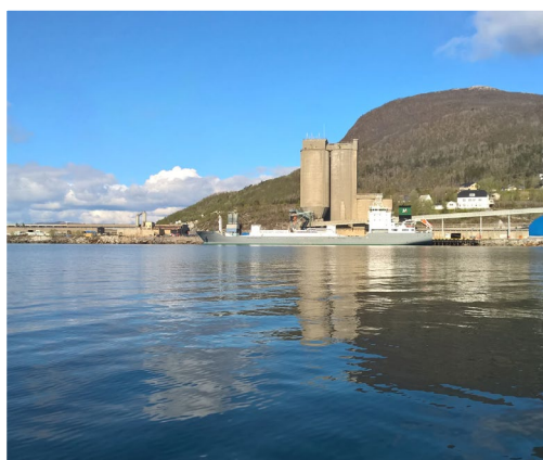
Unten links: Kjøpsvik, Norwegen (Rauchgasreinigungsanlage)
